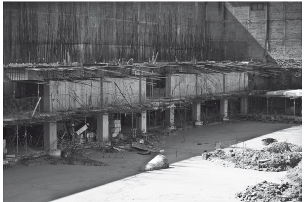
Construcción en Aztecas 215
