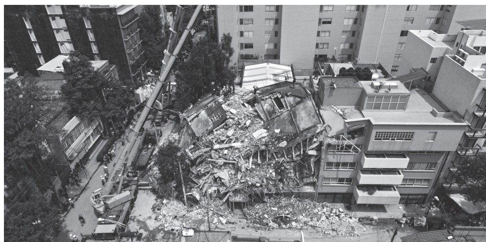
Derumbe en la esquina de Gabriel Mancera y Escocia tras el sismo del 19 de septiembre. Tomada de internet
